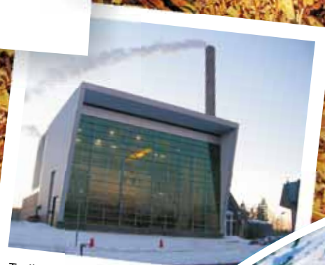
Trollhättan Energi Schweden 3,5 MW e / 17 MW th
